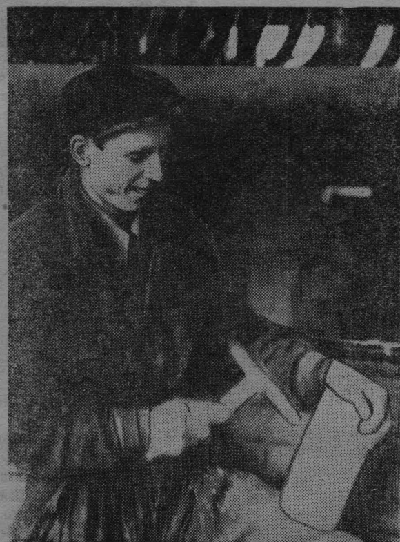
На шахте имени С. М. Кирова ремонтировалась парокотельная. Потребовалось срочно произвести обмуровку котлов ДКВ-10/13. Руководители Ленинского стройуправления треста «Ленинуголь» направили сюда четырех лучших каменщиков из бригады Владимира Яковлевича Покидько. Среди них оказался и комсомолец Виктор Вегнер. У него только пятый разряд каменщика, но он успешно выполняет работы шестого разряда. Выполнение норм у комсомольца Вегнера составляет ежедневно более 150 процентов. Это его подарок 40-й годовщине Ленинского комсомола и XXI съезду КПСС. На снимке: комсомолец Виктор Вегнер за работой.
