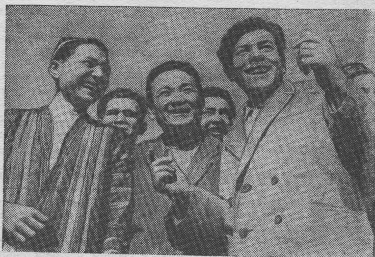
Узбекская ССР. Бригада арматурщиков Петра Иванцова Термезского 165-го строительного управления одержала большую трудовую победу. За одиннадцать месяцев она выполнила два годовых плана. На днях ей присвоено звание коллектива коммунистического труда.
