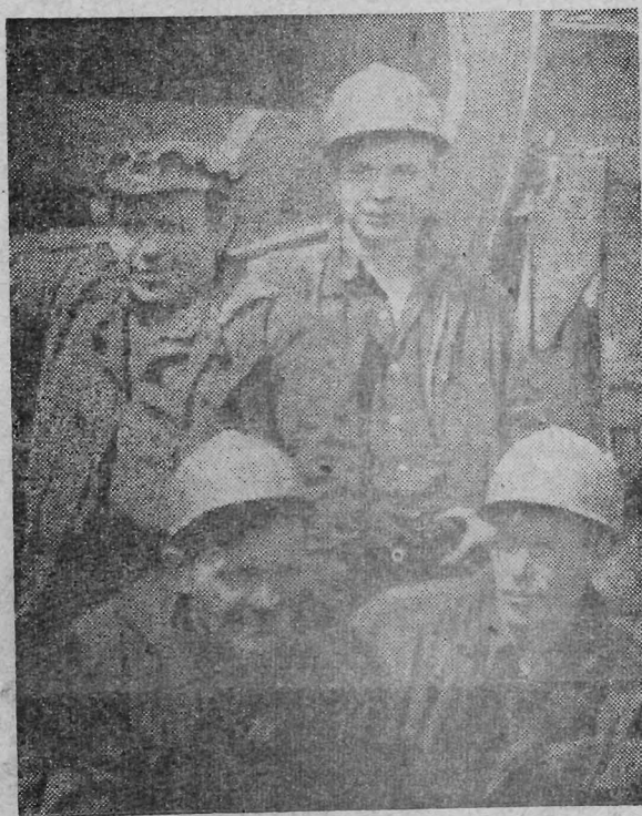
Планово-предупредительный ремонт опрокидов, электровозов, всего подземного транспорта должны производить электрослесари ВШТ.
