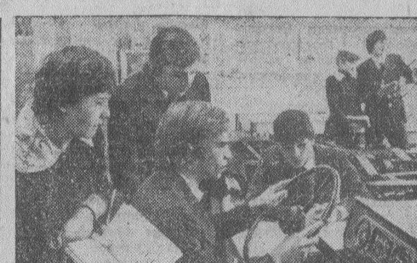
Специальный класс по автоделу оборудован в Новгородской средней школе № 10. В нем установлены шасси грузовой автомашины, тренажер для отработки правил вождения автотранспорта, имеются различные макеты.
