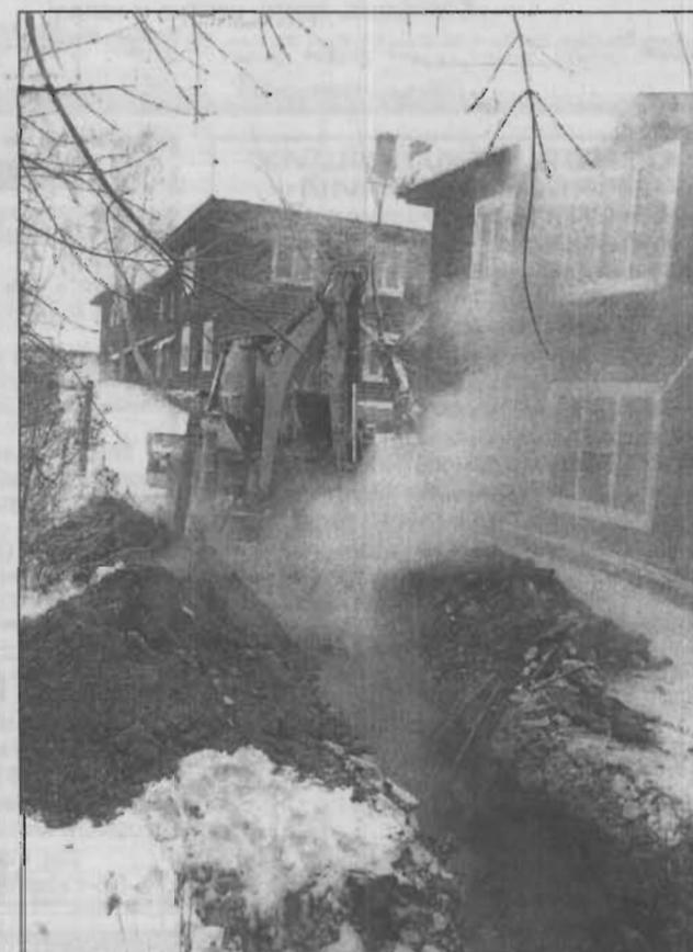
рыв 400-миллиметровой трубы. У автодороги с интенсивным движением. С затоплением не только теплокамеры и всего бетонного желоба в вырытой траншее, но и подвала четырёхподъездной пятиэтажки. Быстро прибыли сюда две асмашины, землеройки. Но самой высокой оценки заслужила работа сварщика Александра Чернышова и слесаря Владимира Капишина, без единого перекура колдовавших над трубой, но обуздавших её кропотливой сваркой.
