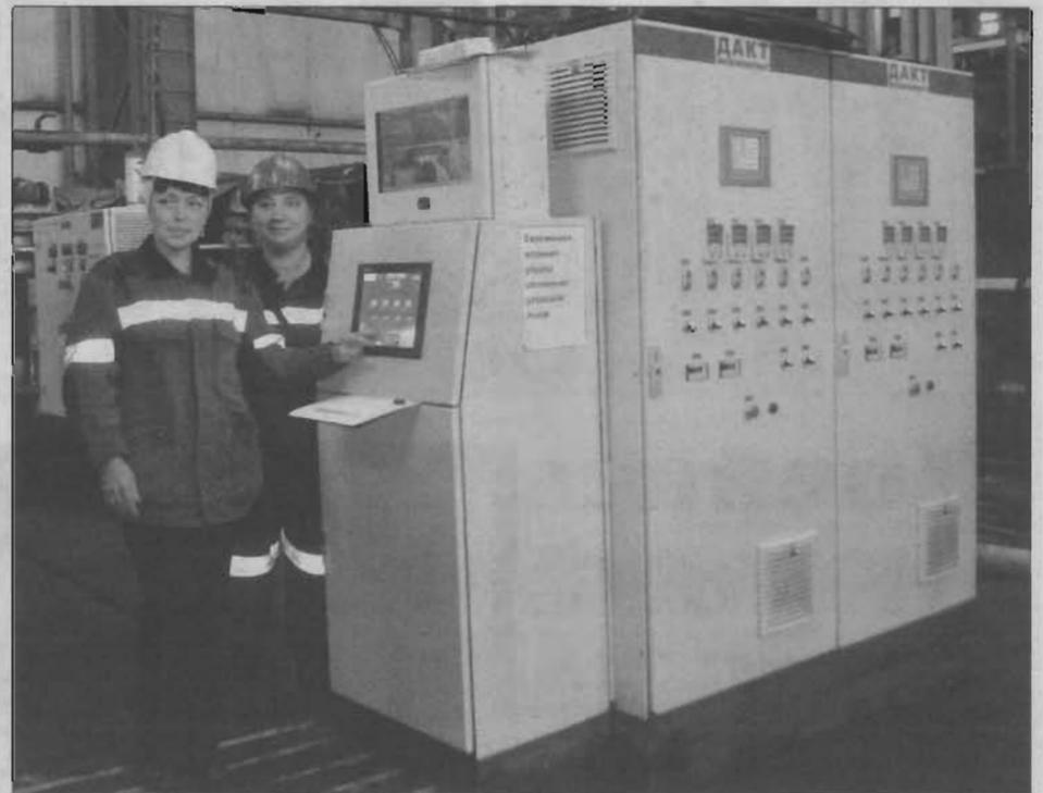
ностями, отслеживая работу отсадочной машины, радиальных сгустителей, конвейеров, пожарной насосной станции, других объектов. Компьютеры также покажут, идёт ли добыча угля на шахте, сколько его в данное время находится на складе, каково натяжение лент, в норме ли обезвоживание горючей массы, расход электроэнергии.
