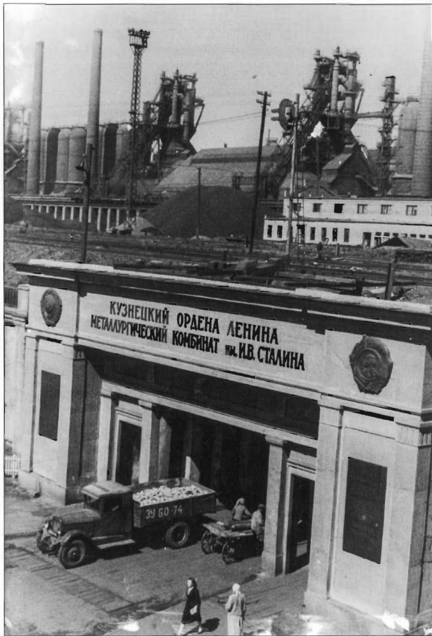
Проходная Кузнецкого металлургического комбината, г. Сталинск. 1945 г. ГКУ ГАК. Фотофонд. Оп.8д. Д. 337. Л. 1.
