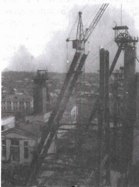
Монтаж нового копра на скиповом подъеме. 1977 г.
