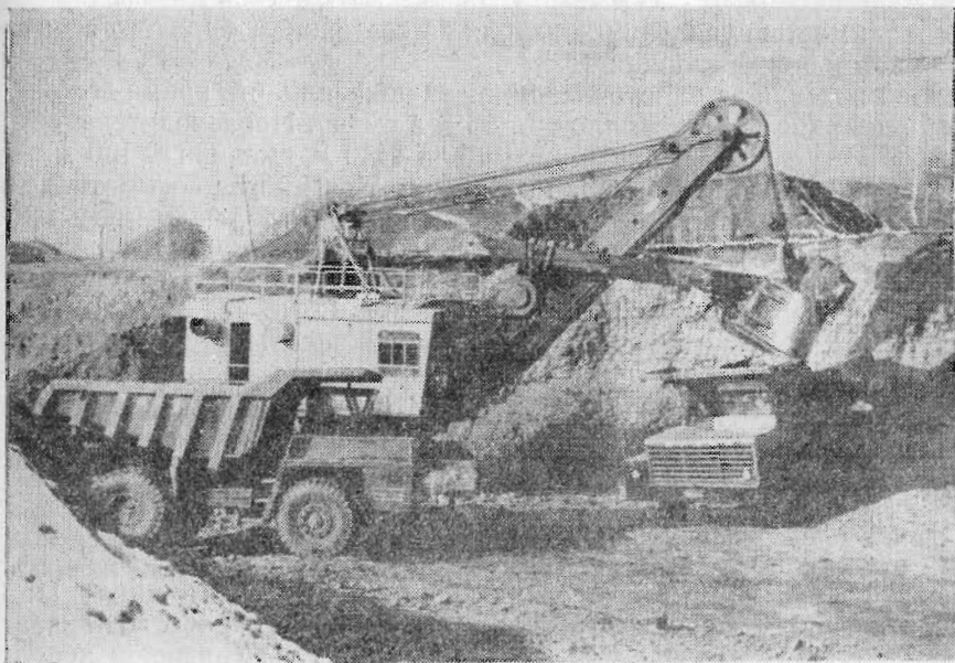
Рис. 84. Двухсторонняя установка автомобилей под погрузку породы
